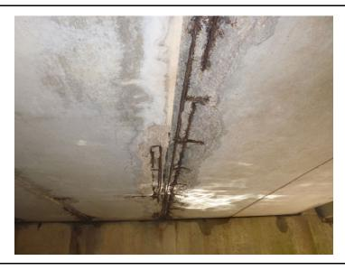
TYPICAL HEAVY SPALLING ON UNDERSIDE OF BEAMS
